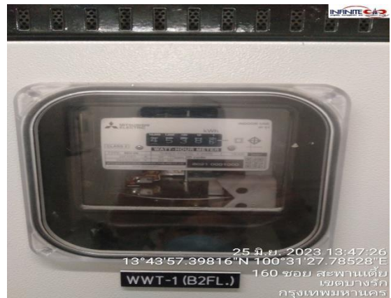
รูปที่ 1.6-4 มิเตอร์ไฟฟ้าของระบบบำบัดน้ำเสีย
